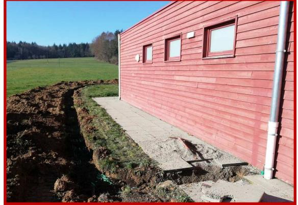
**Enfouissement** d'une gaine vidéo véhiculant la fibre optique par l'entreprise SAUNER Montant: 576€.HT
