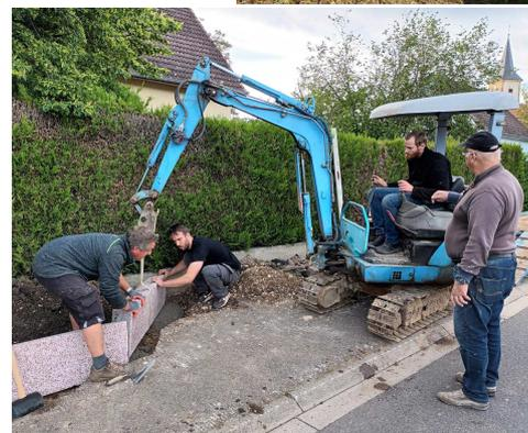
une barrière comportant des poteaux en granit, reliés entre eux par une main courante en bois. Les uns ont creusé les trous, les autres y ont placé les poteaux et ajusté les bois ronds. Puis les poteaux ont été bétonnés, et un banc en pierre a été placé, pour que le site soit accueillant.
