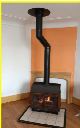
Mise en place d'un tubage de cheminée pour utiliser un poêle bois au niveau de l'appartement du presbytère. (financé par la convention bâtiment culturels).
