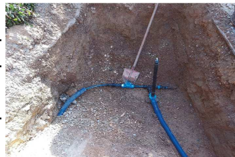
Renouvellement d'un branchement à Traubach le Haut
