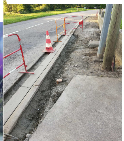
Reprise de bordures et pose d'enrobé à plusieurs endroits dans la commune.
