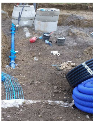
Mise en place d'un nouveau branchement d'eau à Traubach-le-Bas
