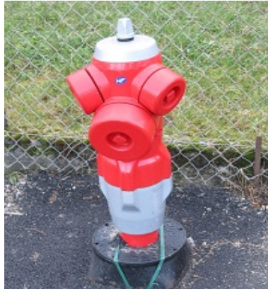
Remplacement de 2 hydrants
