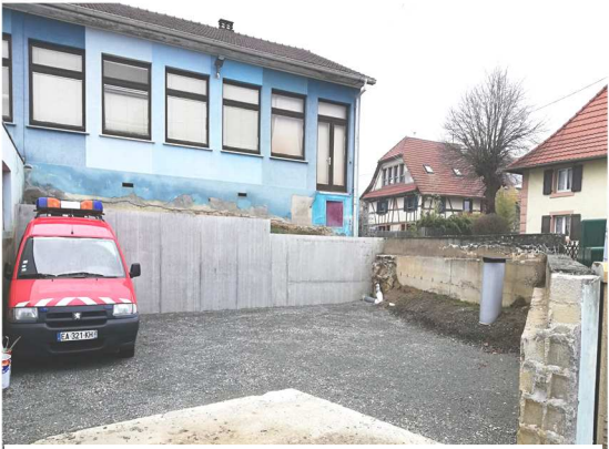
Mur de soutènement et Placette Caserne.
