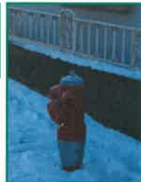
Remplacement d'une bouche d'incendie défectueuse par un poteau d'incendie. (Rue de Masevaux)
