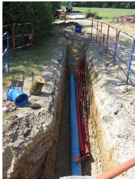
La nouvelle conduite d'une longueur de 616 ml a été posée le long du chemin forestier à partir de la réserve enterrée avant le surpresseur.
