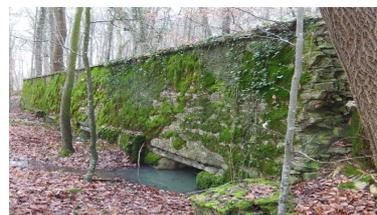
Au-dessus, une dalle bétonnée de 8 cm d'épaisseur surplombant le mur de 6 cm achève de belle manière l'ouvrage. Par contre l'arrière est beaucoup moins soigné, les blocs de pierre ont été scellés grossièrement avec du béton et sans aucune finition.
